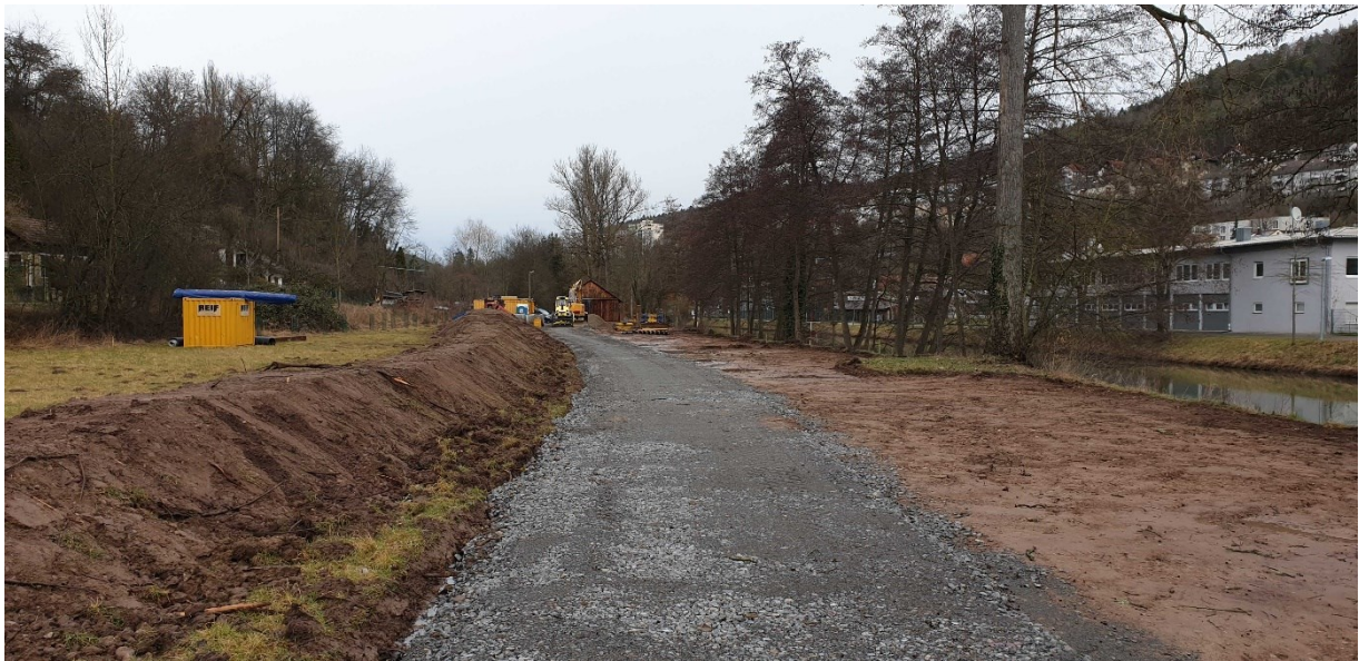
Kanaltrasse und Baustraße
