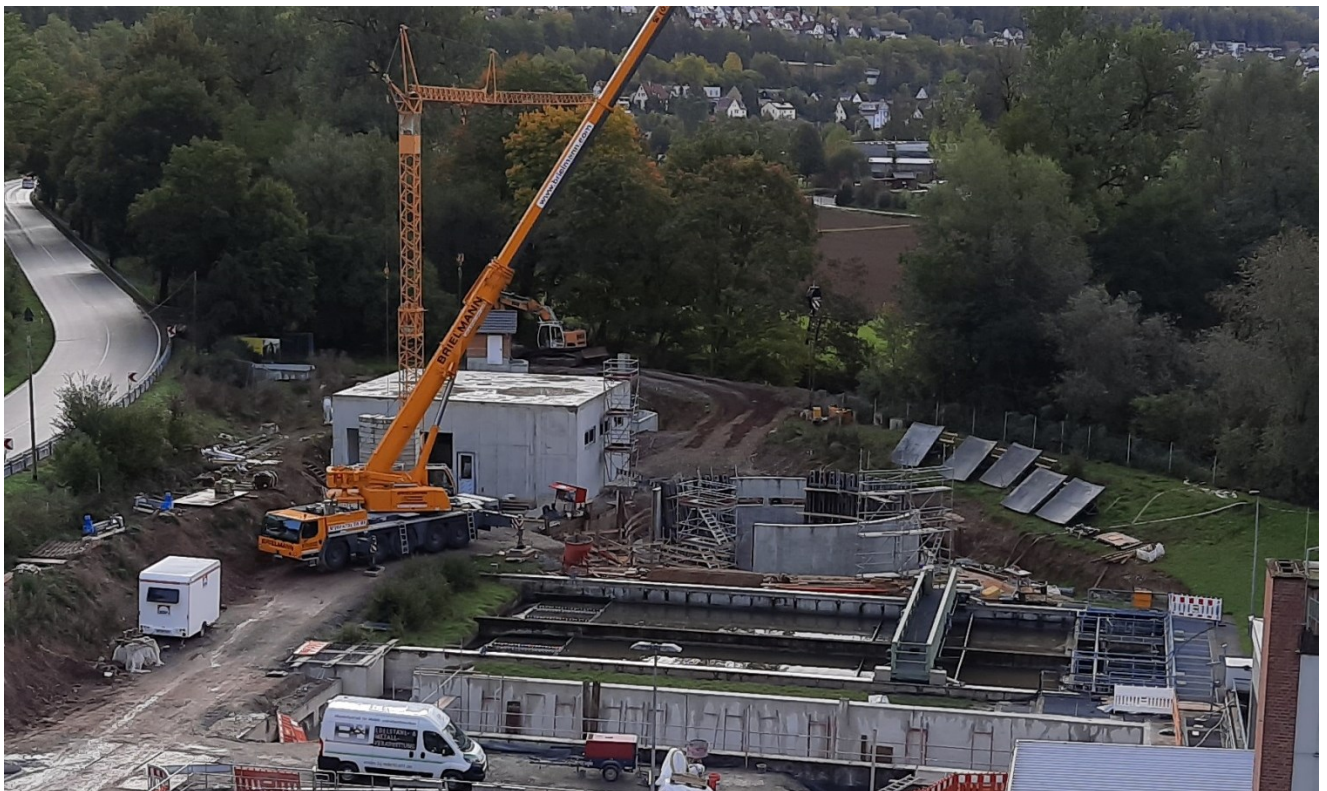
Baustelle Rechen- und Sandfang und RÜB Neubau
