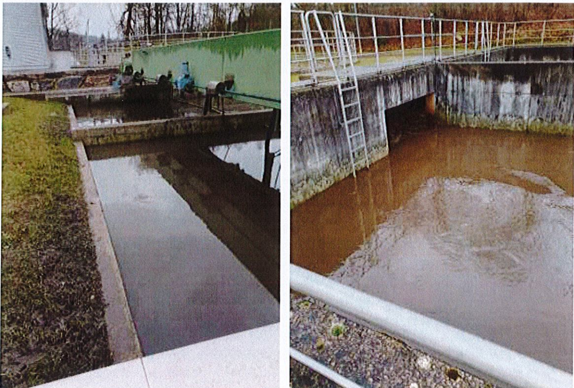
Abbildung 6: Wasserspiegel Ablauf Vorklärung (links) und Ablauf Denitrifikation (rechts)
