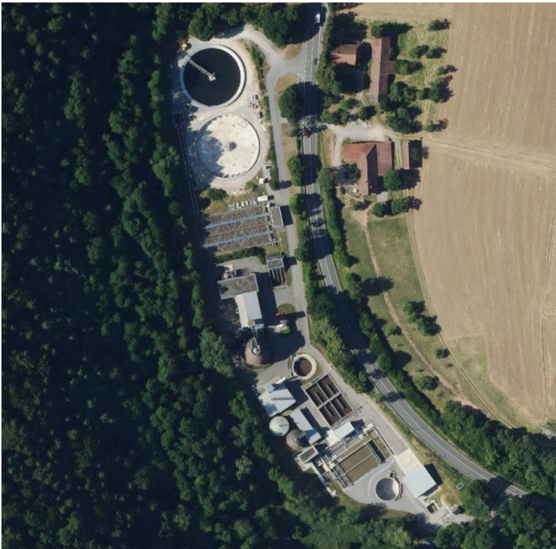
Abbildung 1: Luftbild der Kläranlage Nagold [Quelle: Kartendienst LUBW, abgerufen am: 28.01.2025]
